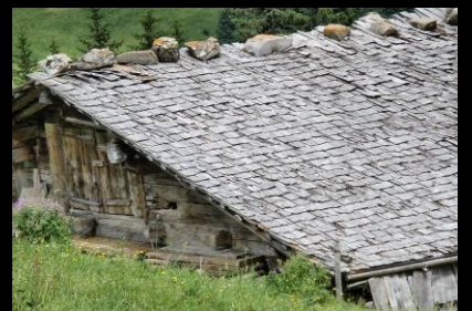
Le bardeau / tavaillon / tavillon planchettes en forme de tuile
